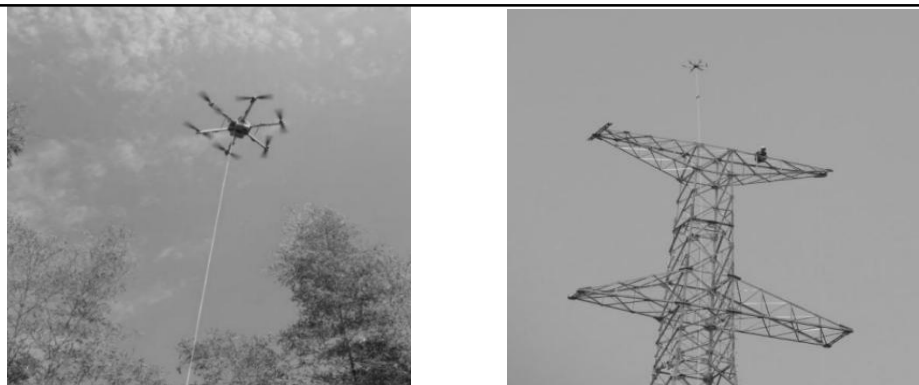
图 2-2 多旋翼无人机放线
